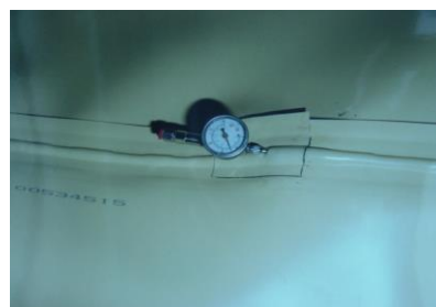
Comprobación de soldadura
