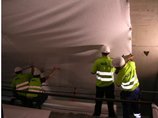
Colocación de geodren.
