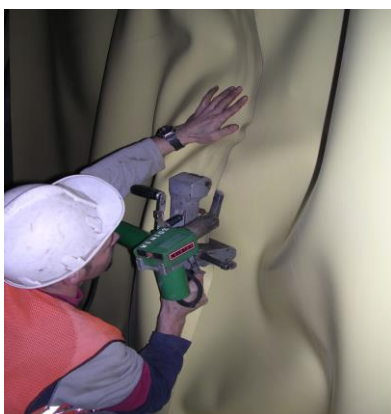
Soldadura por Termofusión.
