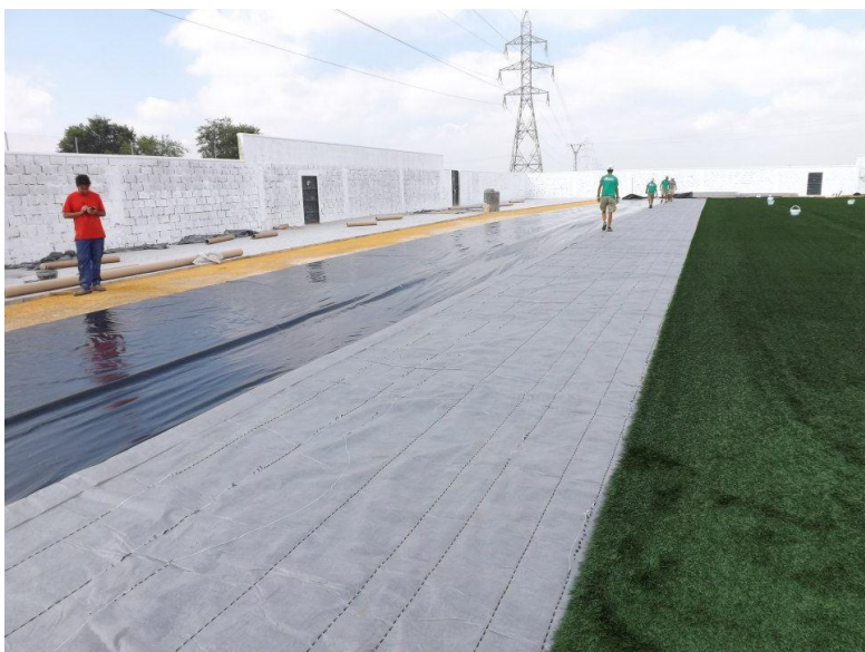
LAMINA IMPERMEABLE ESPESOR 0,20 MM + GEOCOMPUESTO DE DRENAJE ENKADRAIN 5006H.
