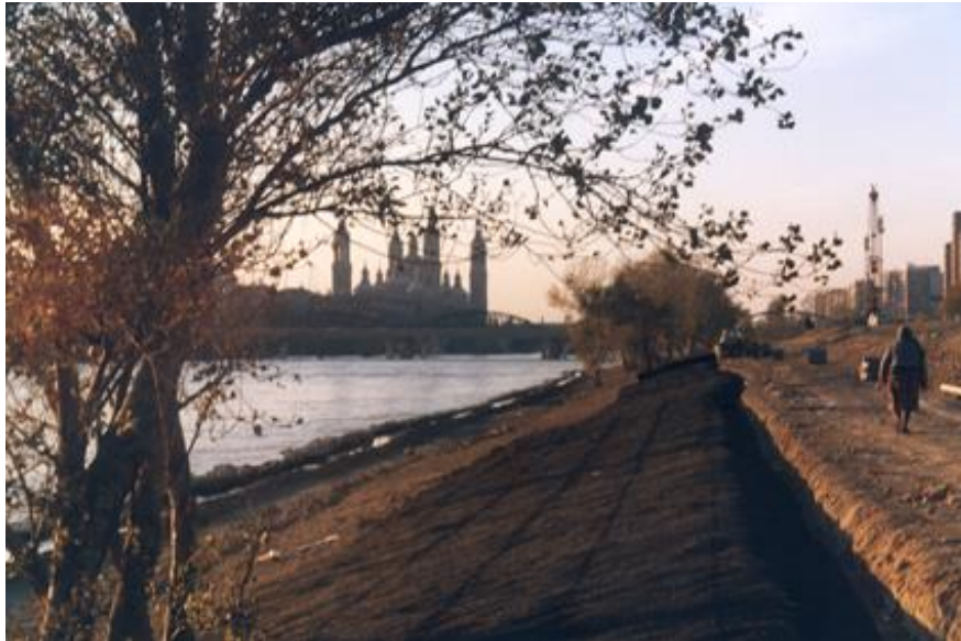
Foto 3: Colocación de la geoestera sobre el talud con su anclaje en la zanja situada en la berma del cauce de avenidas.
