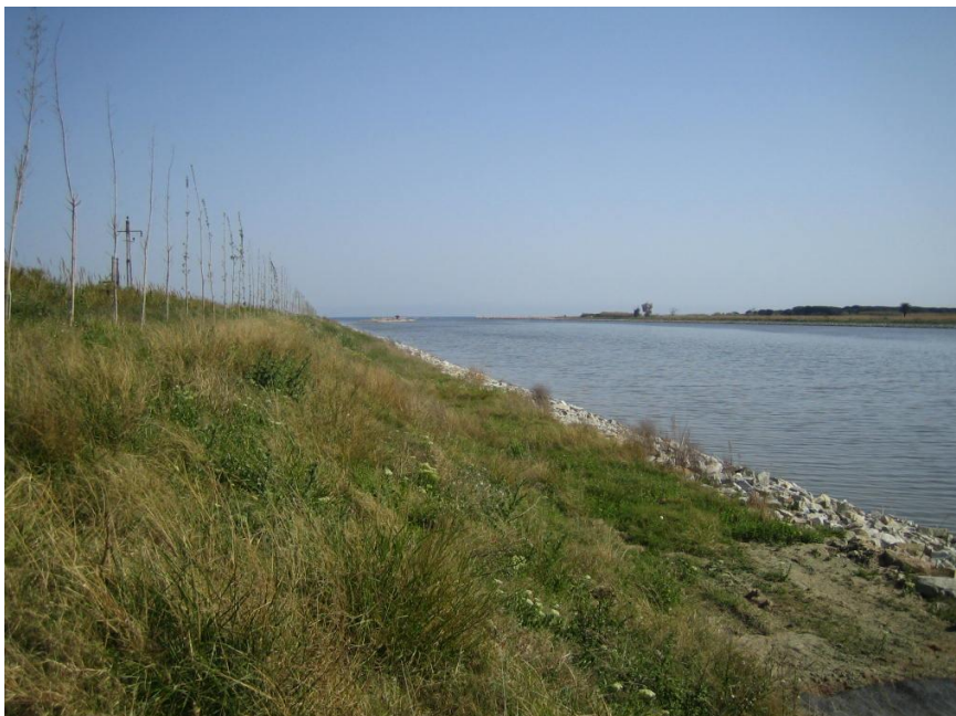
Foto 11 Situación al cabo de unos meses de la terminación de los trabajos.
