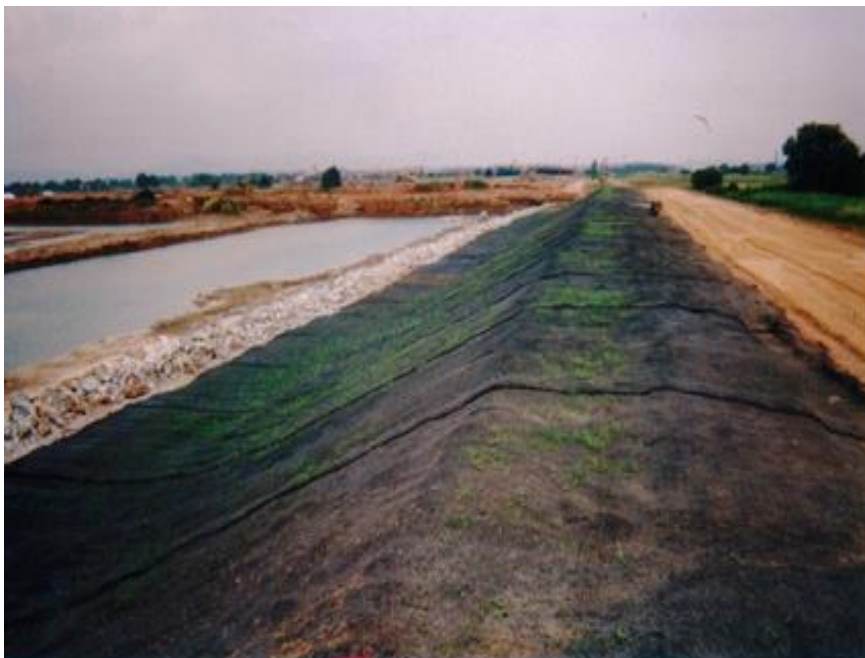
Foto 10 Geostera al poco tiempo de la instalación con establecimiento de cierta vegetación.
