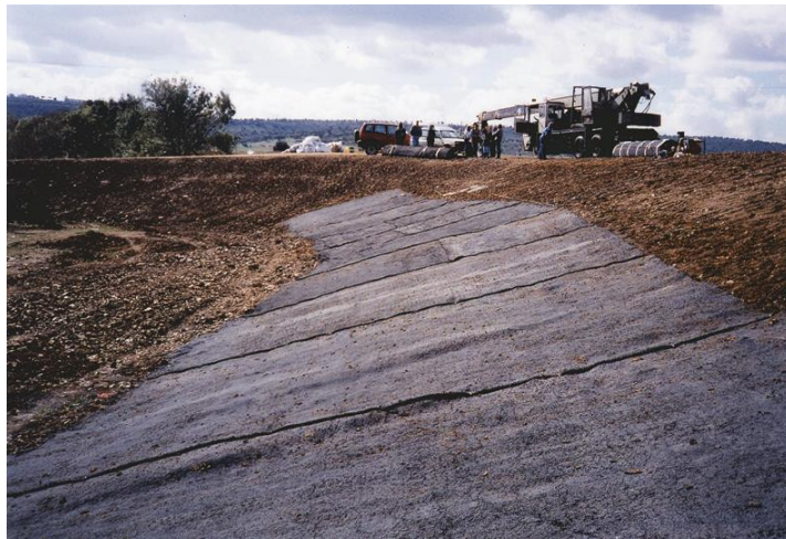
Foto 1: Colocación de la geoestera rellena el talud del cauce de avenidas del Río Matachel.
