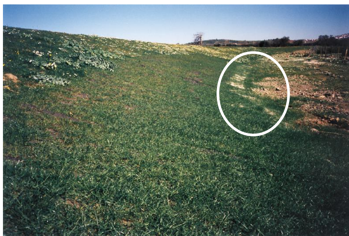
Foto 2: Situación al cabo de 2 meses de la instalación, en la zona inferior del talud (marcado en la foto) baja puede observarse el efecto que sobre la vegetación tuvo la primera avenida.
