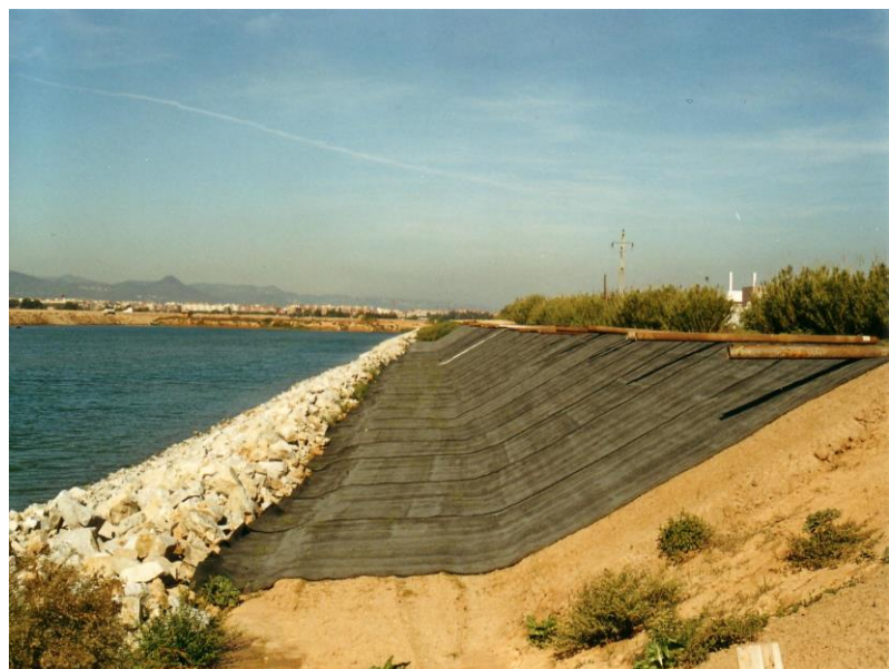
Foto 9 Geoestera sobre el talud recién instalada, anclada en zanja superior e inferior.
