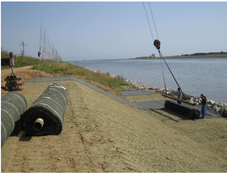
Foto 8 Colocación de la geoestera sobre el talud previamente semillado.
